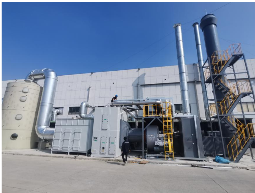
图 4-3 沸石转轮+CO 催化燃烧工程实例图
