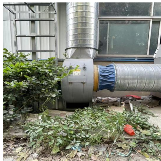
风机基础减震
